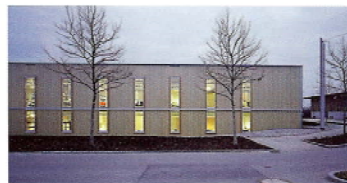
Interne Wärmegewinne und intelligente Konzepte minimieren den Energieverbrauch
