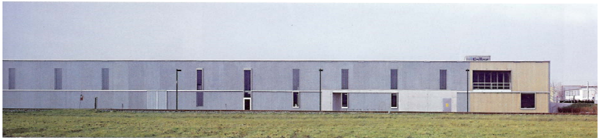
Einfache Industrieverglasung als Gebäudehülle: Das grünliche Glas steht je nach thermischer Anforderung vor einer Beton- oder einer Holzwand
