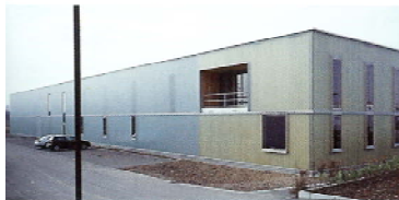
Von außen kaum erkennbar: Gebäudezonierung und Gliederung der Funktionsbereiche
