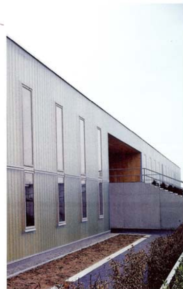
Die Glasfassade ist kontrolliert hinterlüftet und Teil des Klima-Konzeptes
