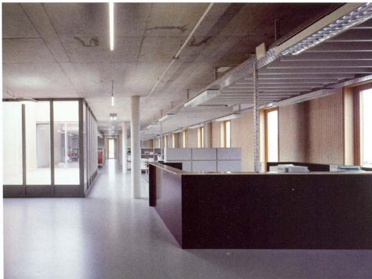
Holz statt Beton: Eine 20 Zentimeter starke Holz-Brettstapelwand sorgt für gute Wärmedämmung nach außen
