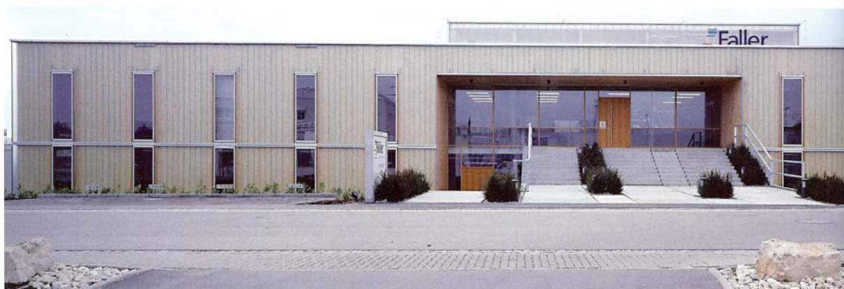
Klare, einfache Linie: Einzig der Eingangsbereich durchbricht die Strukturierung der Fassade
