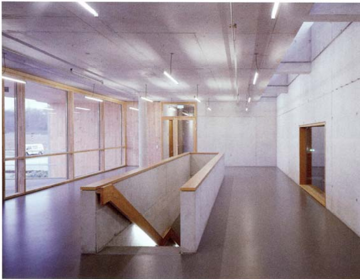
Klare Linien dominieren auch im Inneren: realisiert mit Beton, Holz und Glas. Die Betonkonstruktion dient auch als thermische Speichermasse und sorgt für ein stabiles Klima
