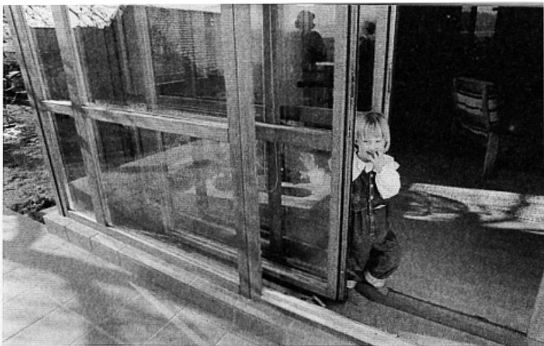
In den vierfach verglasten Fensterkästen erwärmt sich durch Sonne Luft . . .
