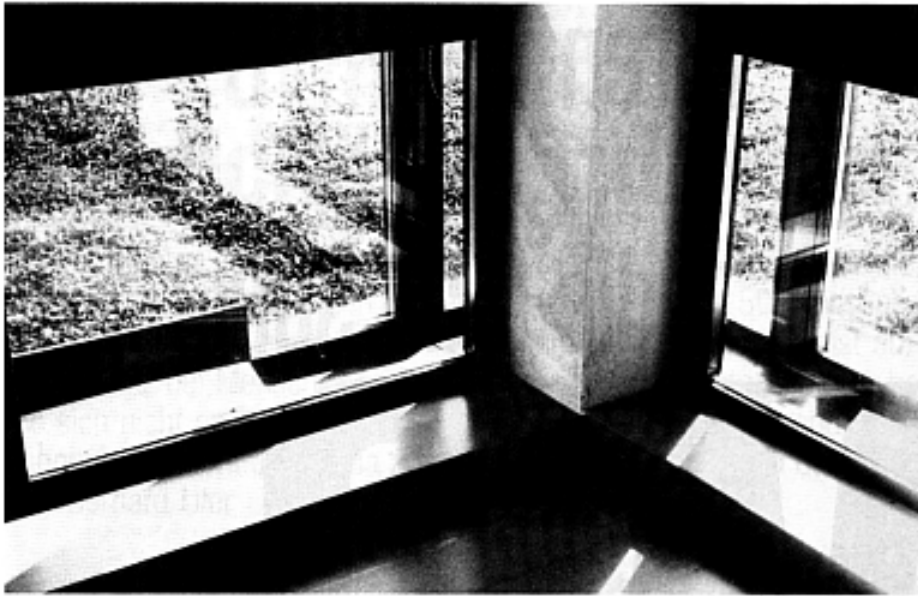
◀ Detail des Fensterkollektors mit Zu- luftklappe.
