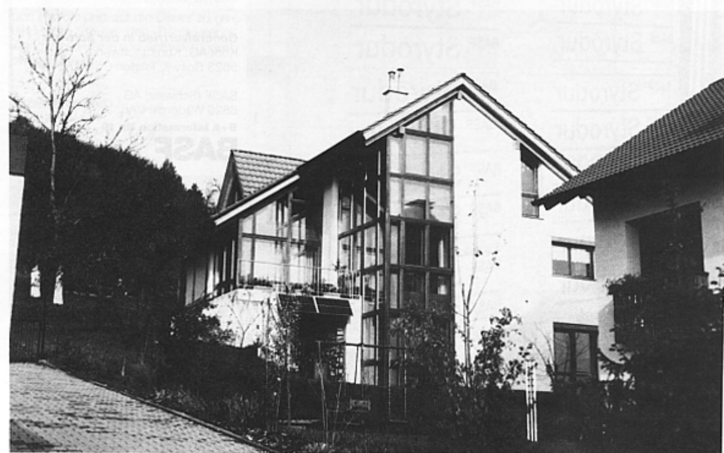
Der 40 m 2 grosse Fensterkollektor mit einer (grössten) Höhe von 11,5 m. Links die Solarzellenanlage (2 m 2 ).
