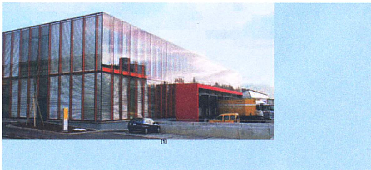
111 Spiel mit Lichtreflexionen mittels bewusst gesetzter Winkelstellungen der Lamellen.
