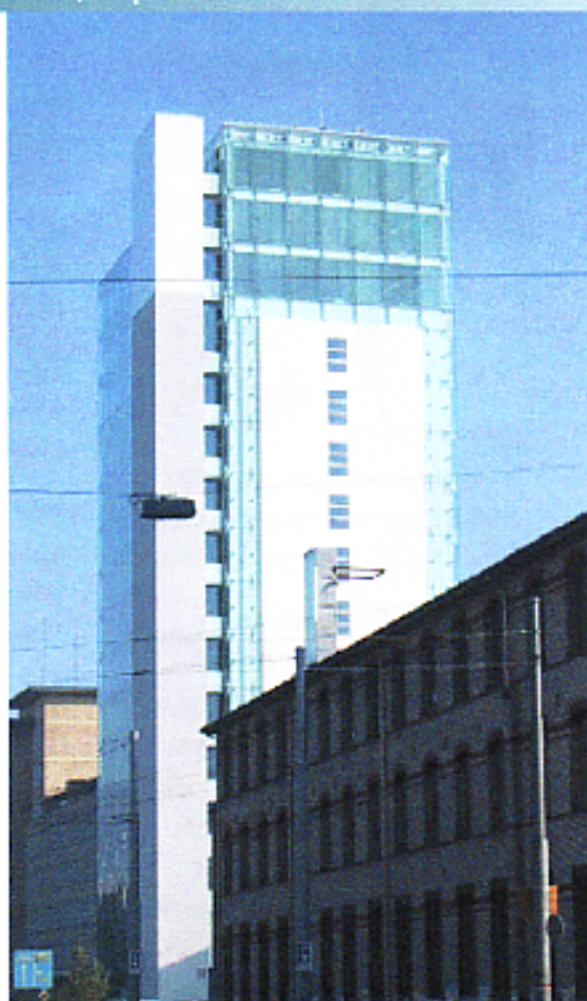
MOBIMO-Hochhaus beim Sulzer-Escher-Wyss- Platz in Zürich
