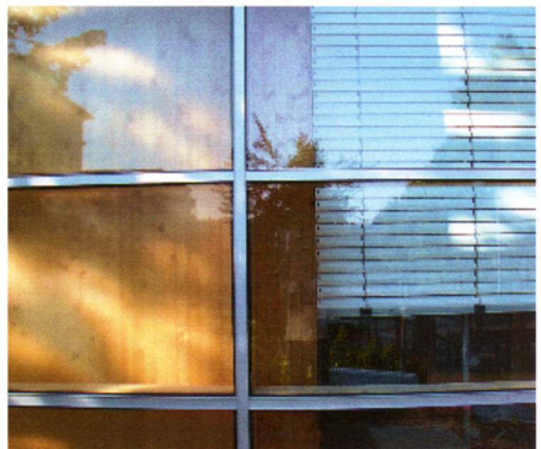
Fassade mit Brettstapeln hinter Glas. (Bilder: Delzer)
